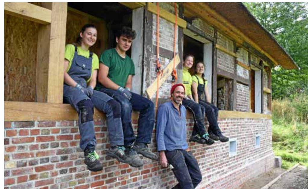
FSJler und der Anleiter der gGmbH Jugendbauhütte Hamburg vor dem alten Hufnerhaus am Moorfleeter Deich, das von den Freiwilligen restauriert wird.
